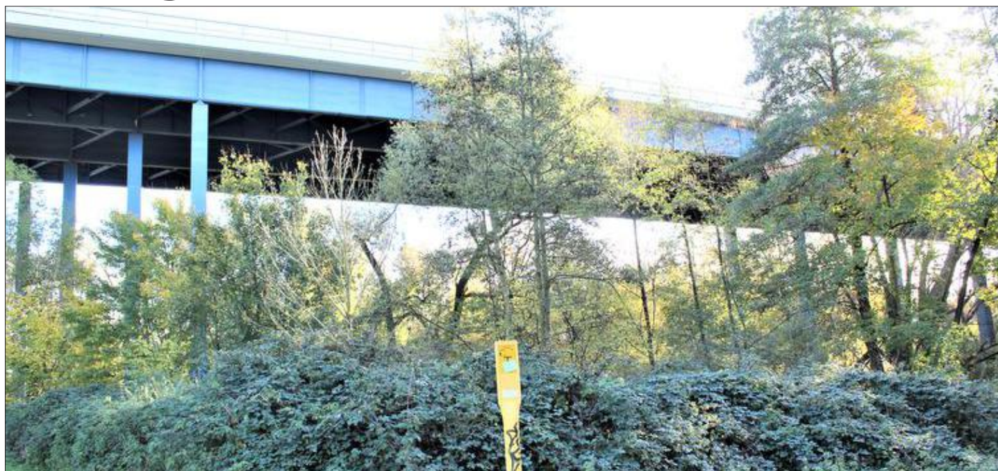
Die Tage der Haarbachtalbrücke, die in die Jahre gekommen ist, sind gezählt: Sie wird abgerissen und neu gebaut. Durch die Vollsperrung lässt sich die Bauzeit der neuen Brücke von zuvor vier auf zweieinhalb Jahre verkürzen. Fotos: Günther Sander
